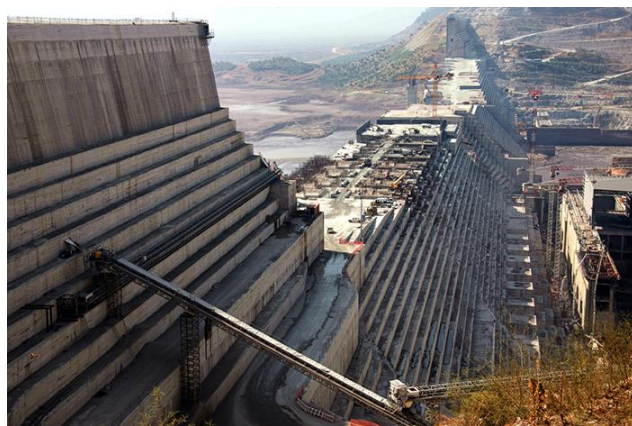
エチオピアが建設中のルネッサンス・ダム
